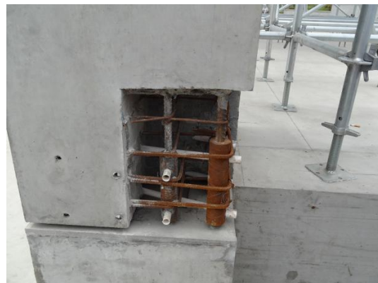
装配式框架和节点示意图
