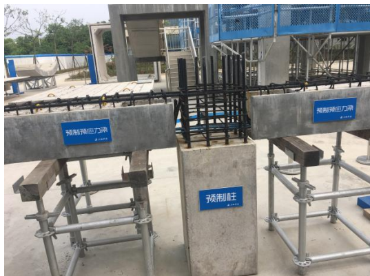
装配式框架和节点示意图
